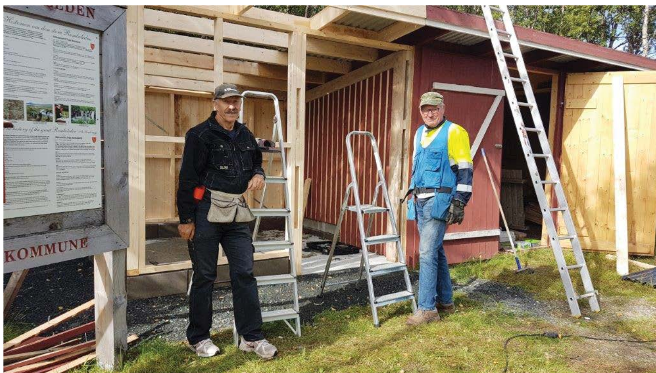
Eivind og Børge i full sving med å bygge nytt redskapshus.
